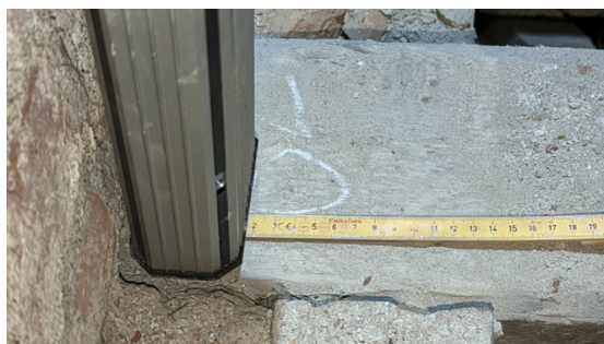
Foto 7. Råtedrillpunkter 3 (ved råtedrillen) og punkt 4 (bak råtedrillen) er boret ca 10 cm fra vegglivet.
