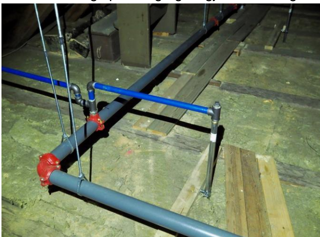
Innvendig sprinkling og rørgjennomføring.
