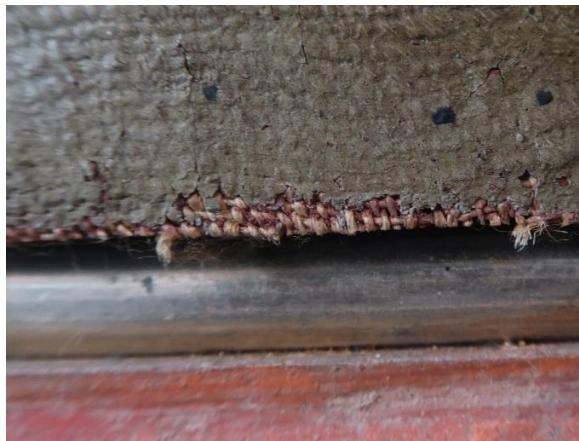
Figur 21. Detalj av malingslaget som går helt ut til kanten av lerretet. Nedre del av maleriet sittet helt løst.
