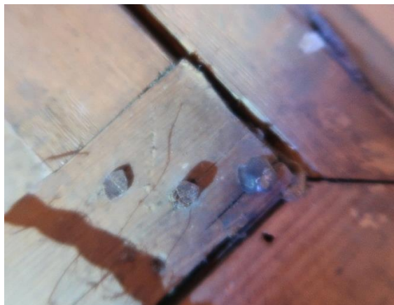
Figur 76. Detalj av fastramme med treplugger.
