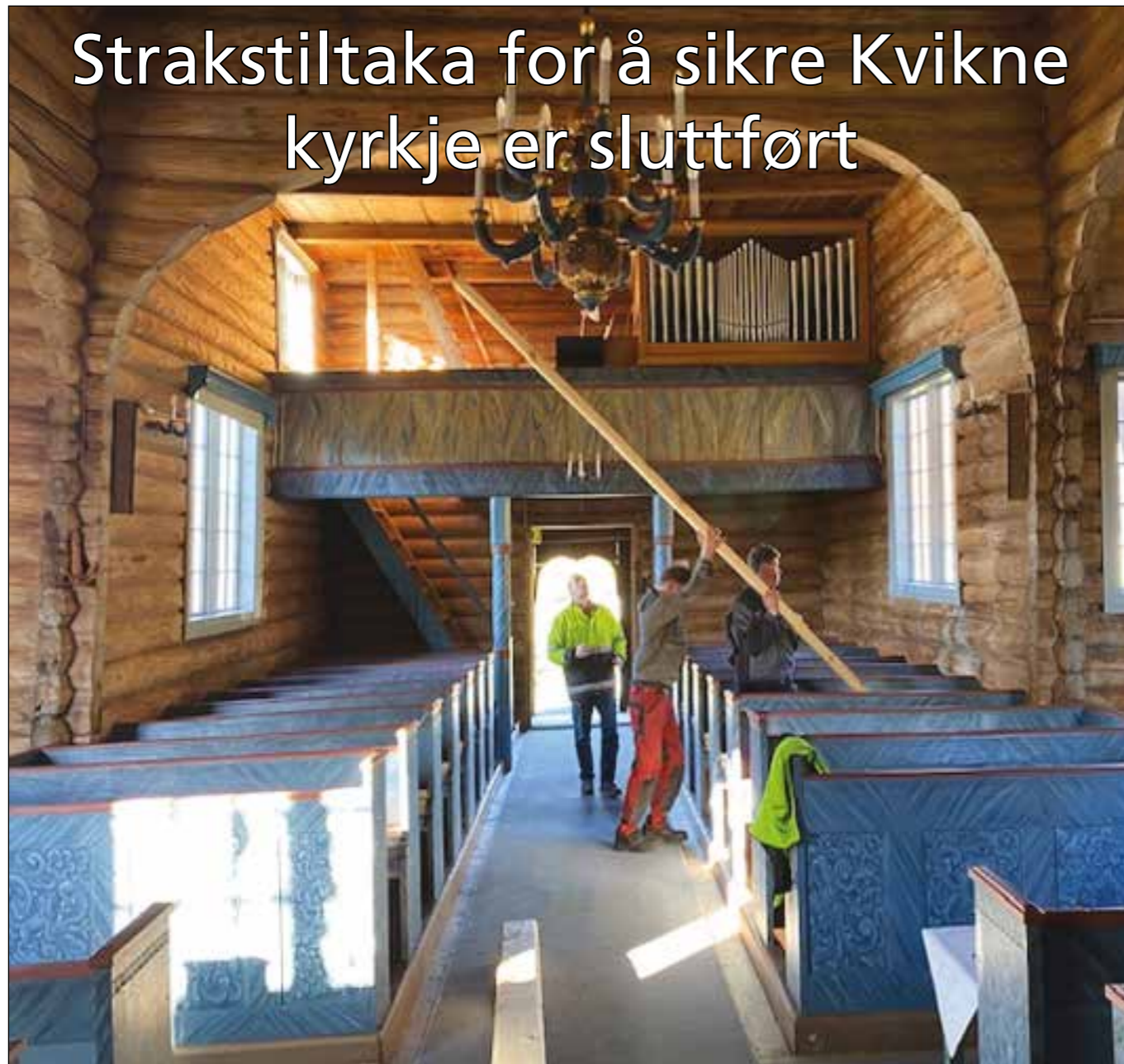
Kraftig trevirke som skal reisast opp.
