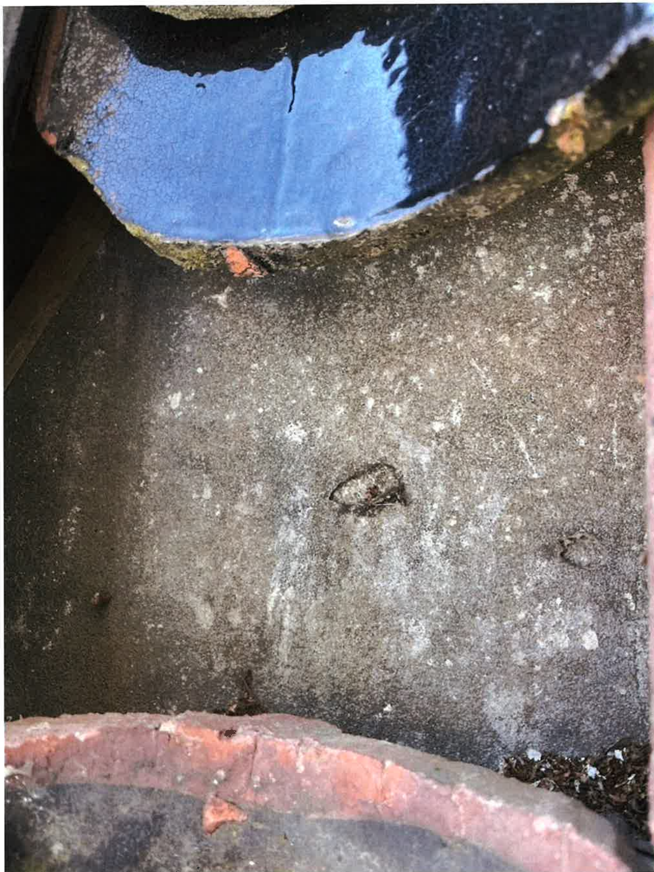
spiker og andre skader på undertak
