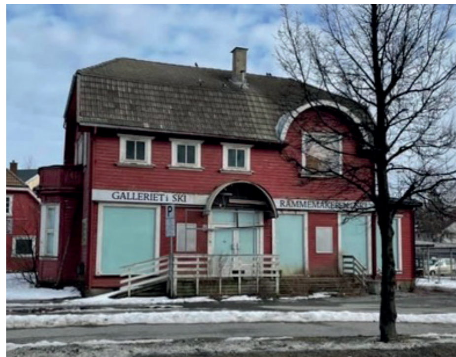
Bygningene skal nå rives. Når det skjer, vil det bli bygget blokker med opptil ni etasjer i området. Ski Historielag har omtalt Framhagen i sin kalender fra 2008 – der informasjon og bilder er hentet fra, samt gammelt bilde fra Gode gamle Skibyen (fotograf ukjent).
