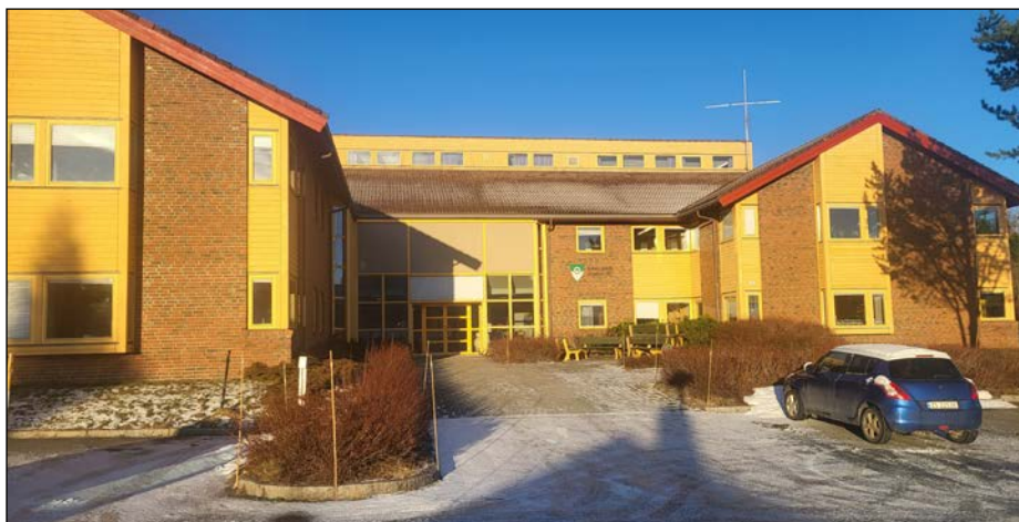
Fra utsiden ser kommunehuset ut som før, men på innsiden har det skjedd store forandringer Foto: Jon Ola Lien
