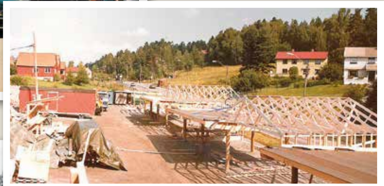
Byggestart på Lerdalsjordet Borettslag i august 1985.
