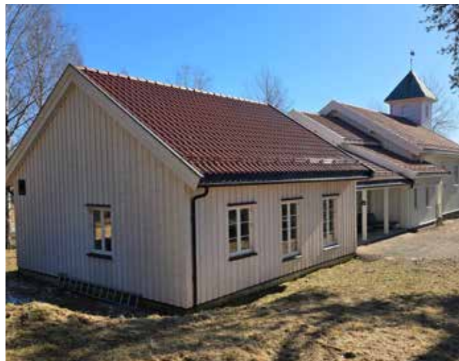
Det har lenge vært behov for et tilbygg med kirkestue og ikke minst toaletter. Påsken 2023 sto bygget ferdig og det har siden vært i flittig bruk til ulike formål. Foto: Gudrun Homstvedt
