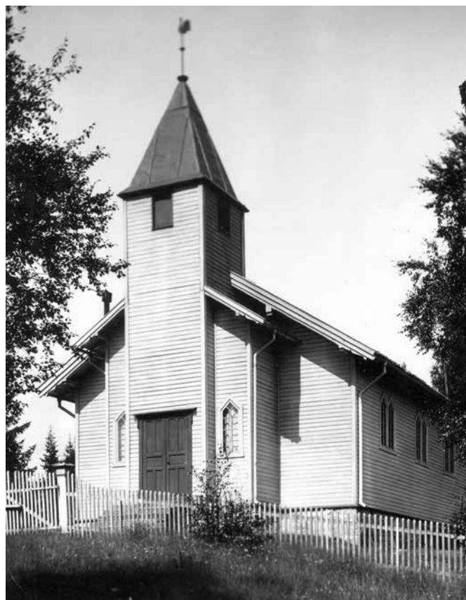
Maridalen kirke med liggende panel og stakittgjerde 1920. Slik så kirken ut fram til renoveringen i 1959. Foto: Oslo Byarkiv
