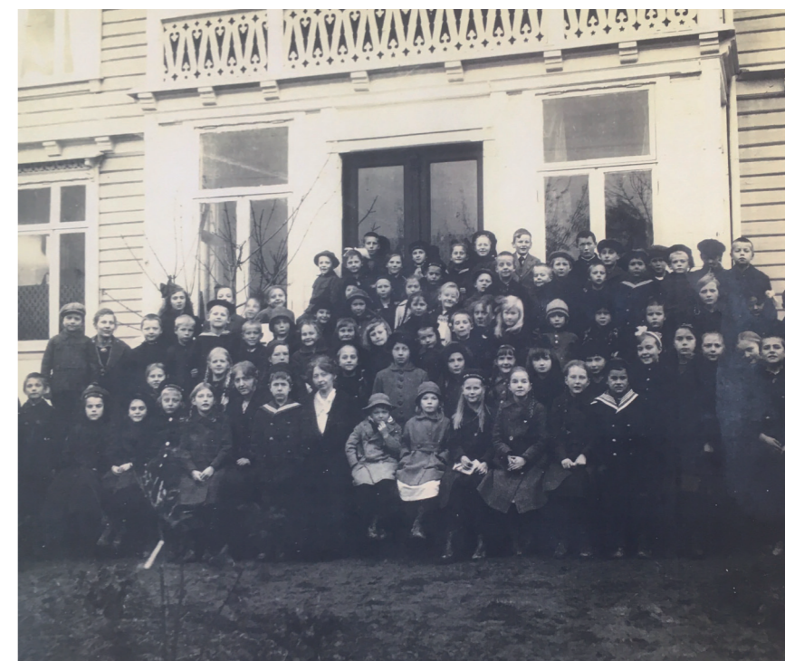
Hele flokken på trappa på Lilleborg. Damen i hvit bluse i første rekke er sannsynligvis frk. Torp. Kopi av original i gangen i seniorsenteret i Poppelstien. På baksiden går det fram at bildet er en gave fra datteren Turid Upsaker Seear i North Carolina, USA.
