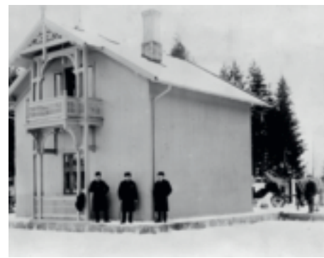
Vanninntakshuset ved Sognsvann som sto ferdig på begynnelsen av 1880-tallet. Vannverket var privateid, men ble overtatt av Kristiania kommune i 1876. Foto: Norsk Teknisk Museum
