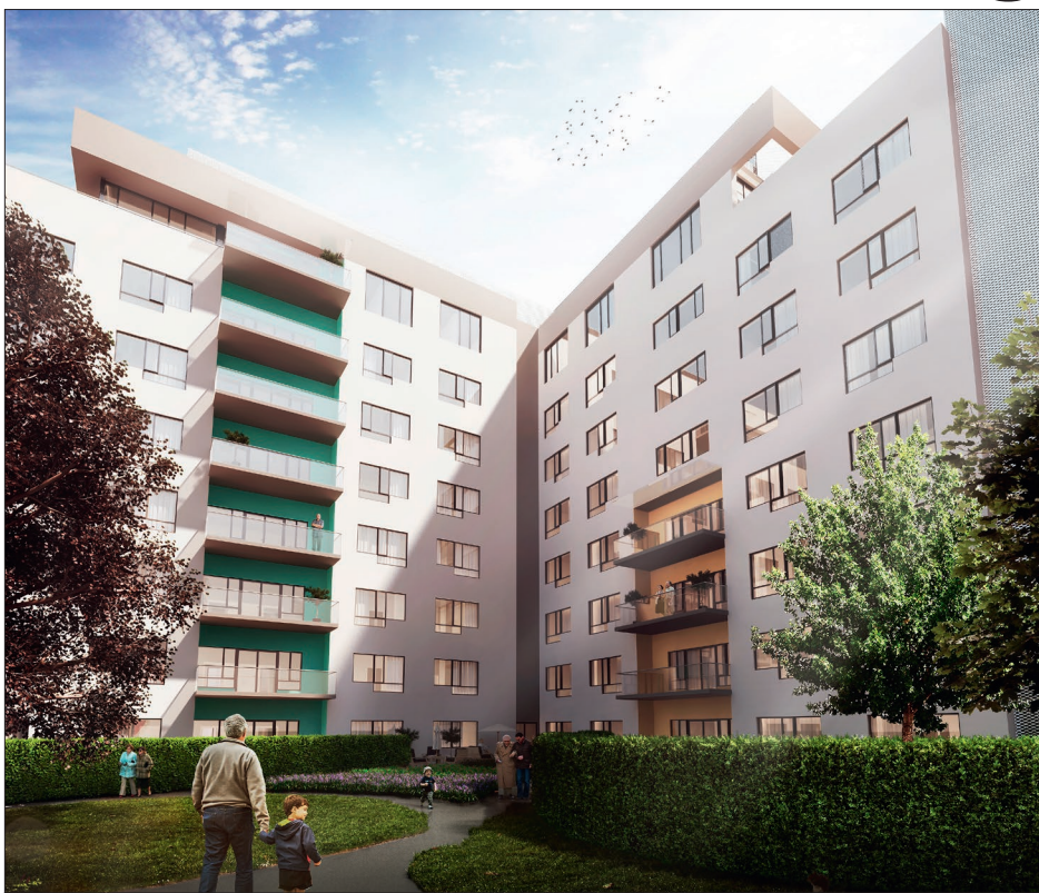
RØAHJEMMET: Slik skal hjemmet se ut når det etter planen skal åpnes den 6. juni.
