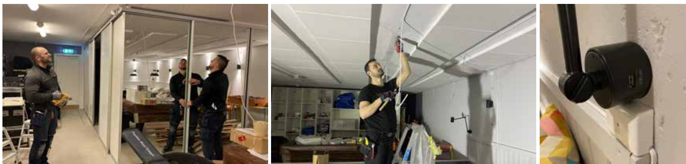
Nye lamper i hele rommet og en ny, stor skyvedørsinnredning.
