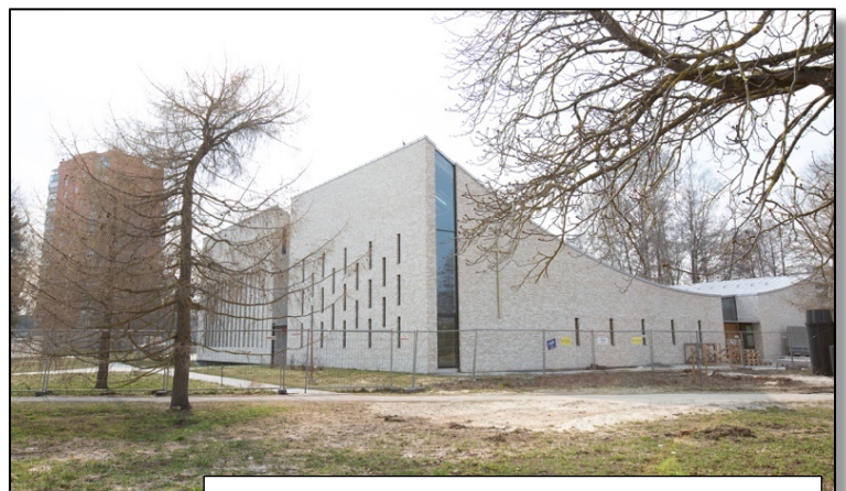
Kirkebygget i Mustamäe er ennå ikke helt ferdig, men noe av den er tatt i bruk.
