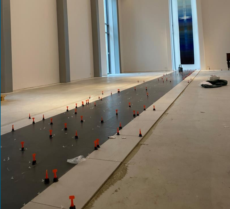
Arbeidet med Saku kirke går stadig framover. Her legges det gulv inne i kirken. Foto: Magne Mølster
