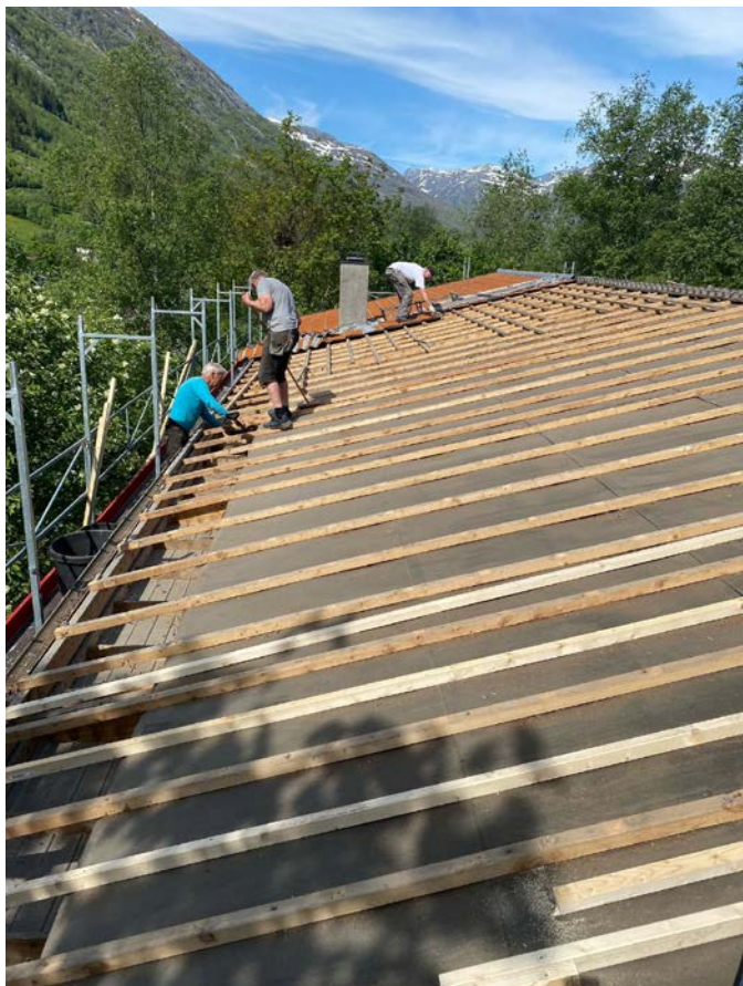
Det gamle taket er fjerna.
