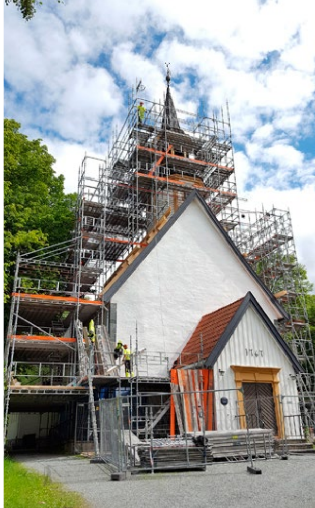
Lade kirke, omfattende stillasarbeid må til ved arbeid på en vernet kirke (Foto: Frode Blomlie)
