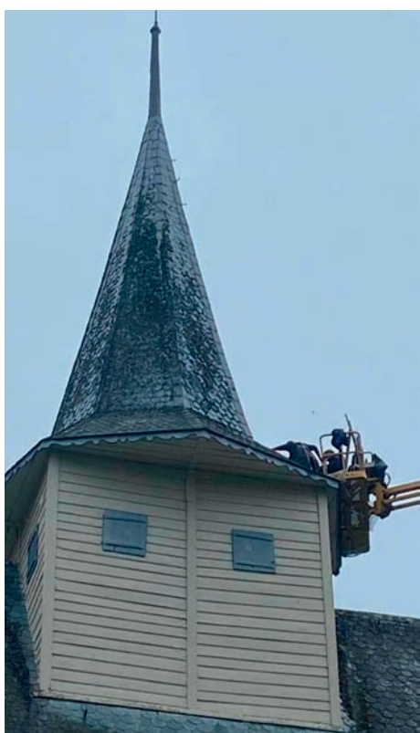
Reparasjon av tårnet.
